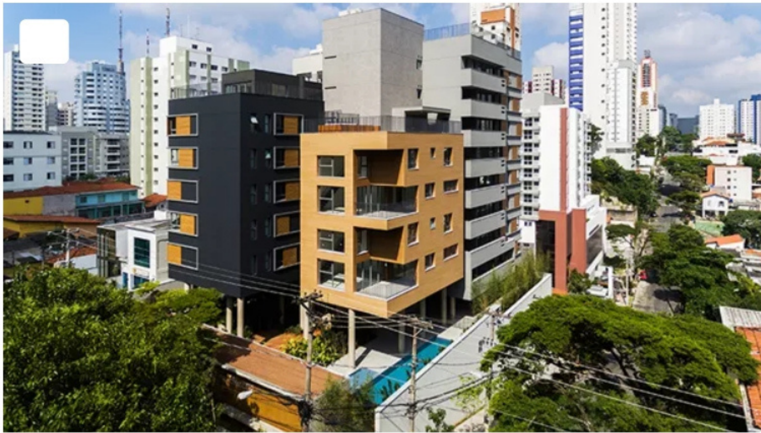
Edifício Aruá, por FGMF (Foto: Reprodução / fgmf.com.br)
